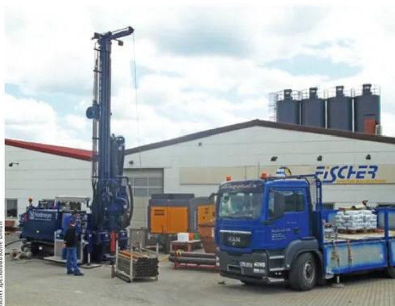
Abb. 1 – Baustelleneinrichtung vor dem Bestandsgebäude der Fischer Spezialbaustoffe GmbH
