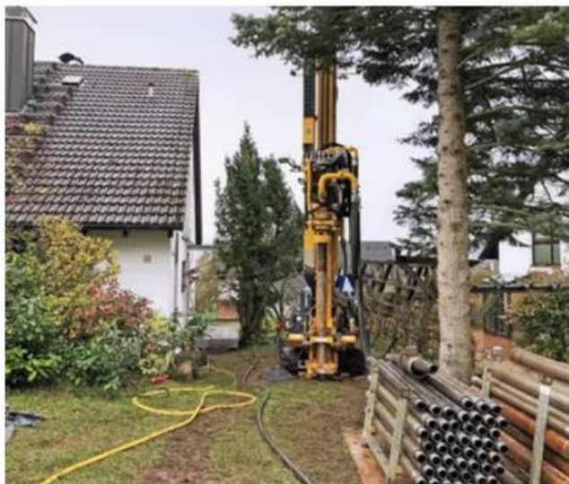
Abb. 4 – Beengte Situation zwischen Wohnhaus und Nachbargrundstück – die Zufahrt, Baustelleneinrichtung und Lagerung ist nur mit Einwilligung des Grundstückseigentümers auf der Gebäuderückseite möglich.
