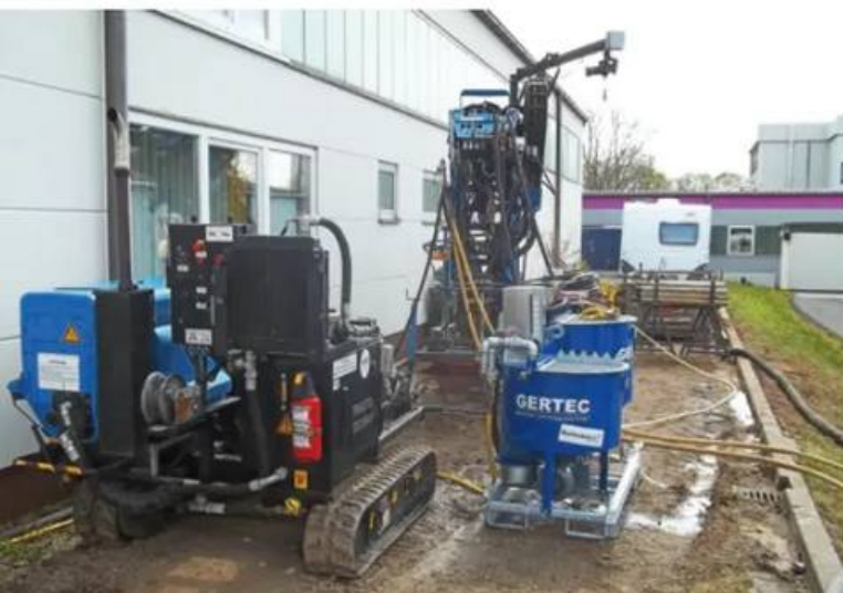
Abb. 3 – GRD-Verfahren von TractoTechnik zu Demonstrationszwecken am „Tag der offenen Baustelle“ 2012 bei der Fischer Spezialbaustoffe GmbH
