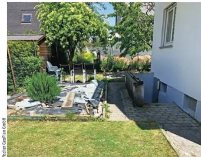
Abb. 2 – Linke Grundstückshälfte eines Einfamilienhauses vor und nach den Bohrarbeiten
