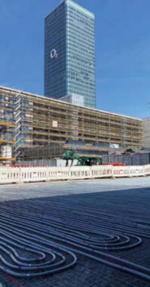
Installation einer Schnee- und Eisfreihaltung am Hauptsitz der Stadtwerke München (Bilder links und mitte). Am größten Paket-Standort Deutschlands in Aschheim bei München wurde eine Erdleitung verlegt (Bild rechts).
