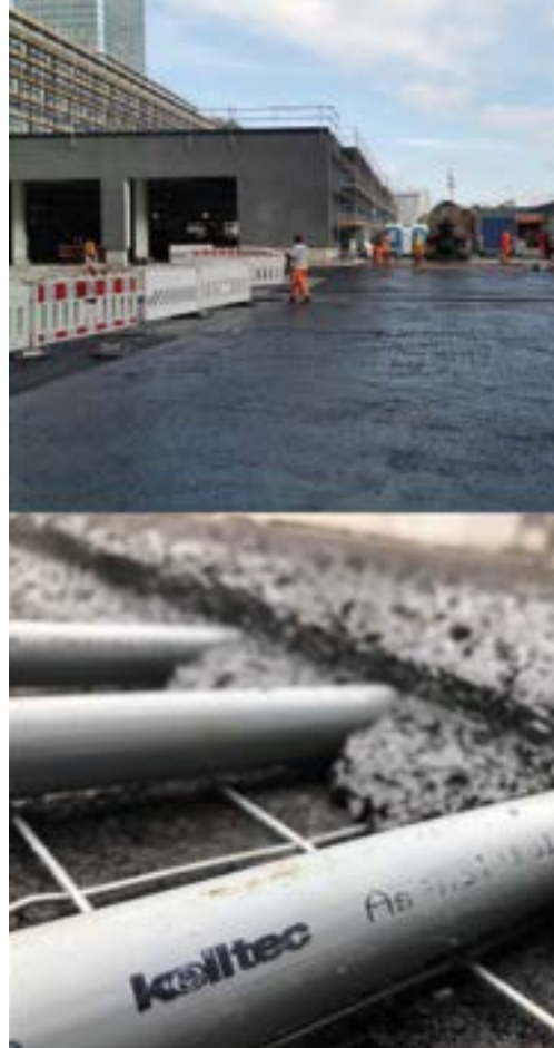
Installation einer Schnee- und Eisfreihaltung am Hauptsitz der Stadtwerke München (Bilder links und mitte). Am größten Paket-Standort Deutschlands in Aschheim bei München wurde eine Erdleitung verlegt (Bild rechts).
